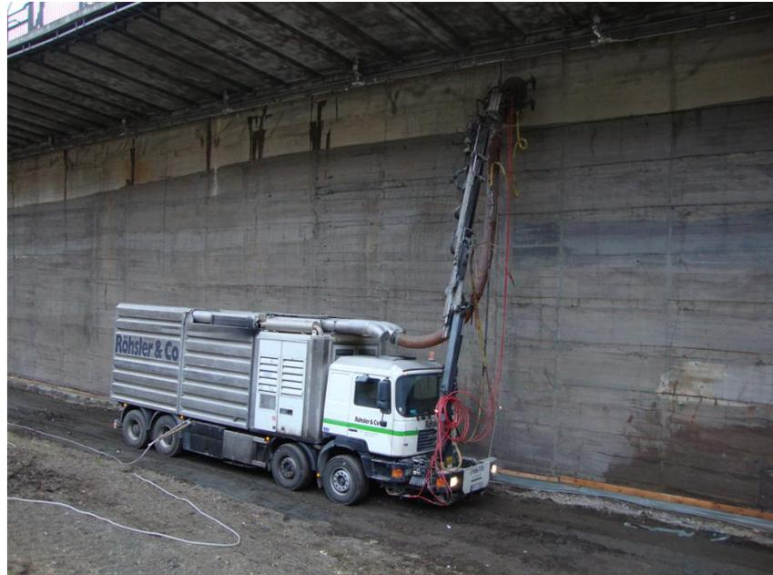
En operaciones de conservación se hace necesaria la limpieza de infraestructuras tales como puentes y túneles. La maquinaria específica para este tipo de trabajos consigue rendimientos de hasta 600 m<sup>2</sup>/h. El equipo está formado por:
