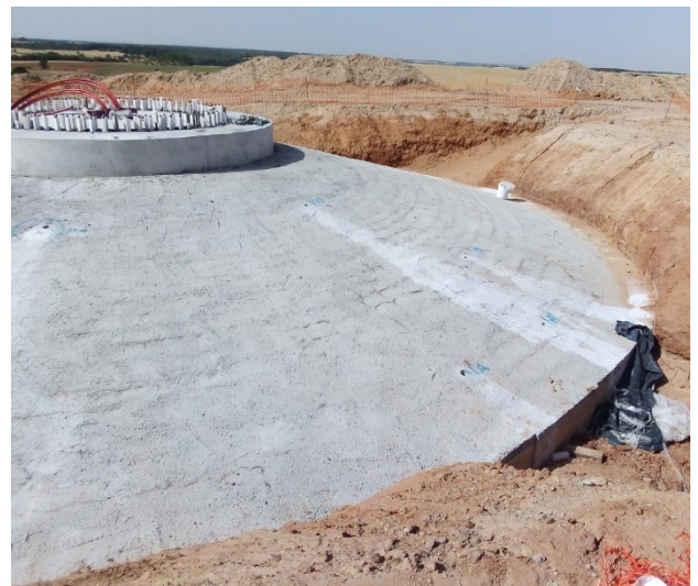
Aplicación en cimentaciones no conformes para la demolición selectiva. Cimentación no conforme en parque eólico
