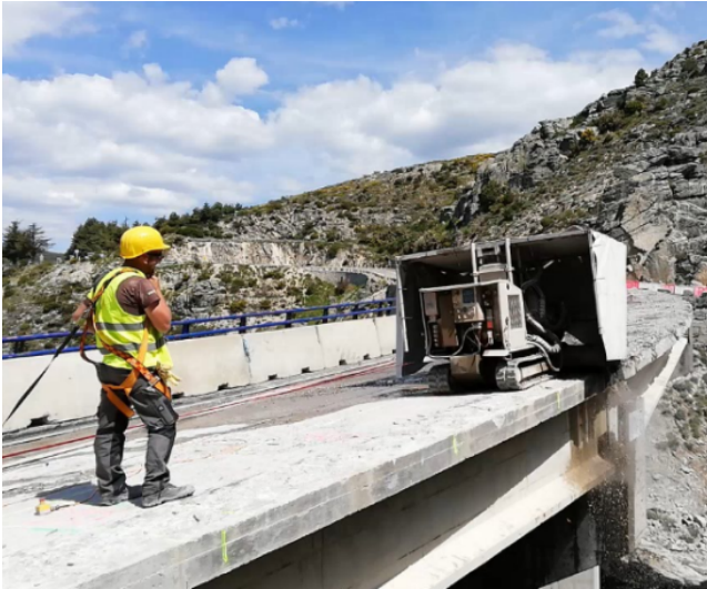
Aplicación en puentes y obras de emergencia con adecuación de sistemas de contención obsoletos
