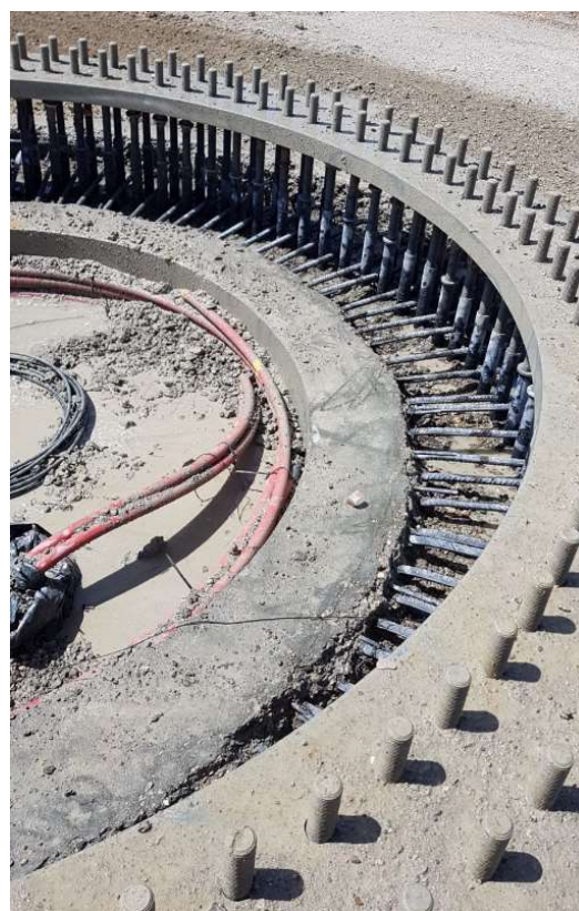
Hidrodemolición de zonas inaccesibles con otros sistemas de demolición en recuperación de cimentaciones especiales
