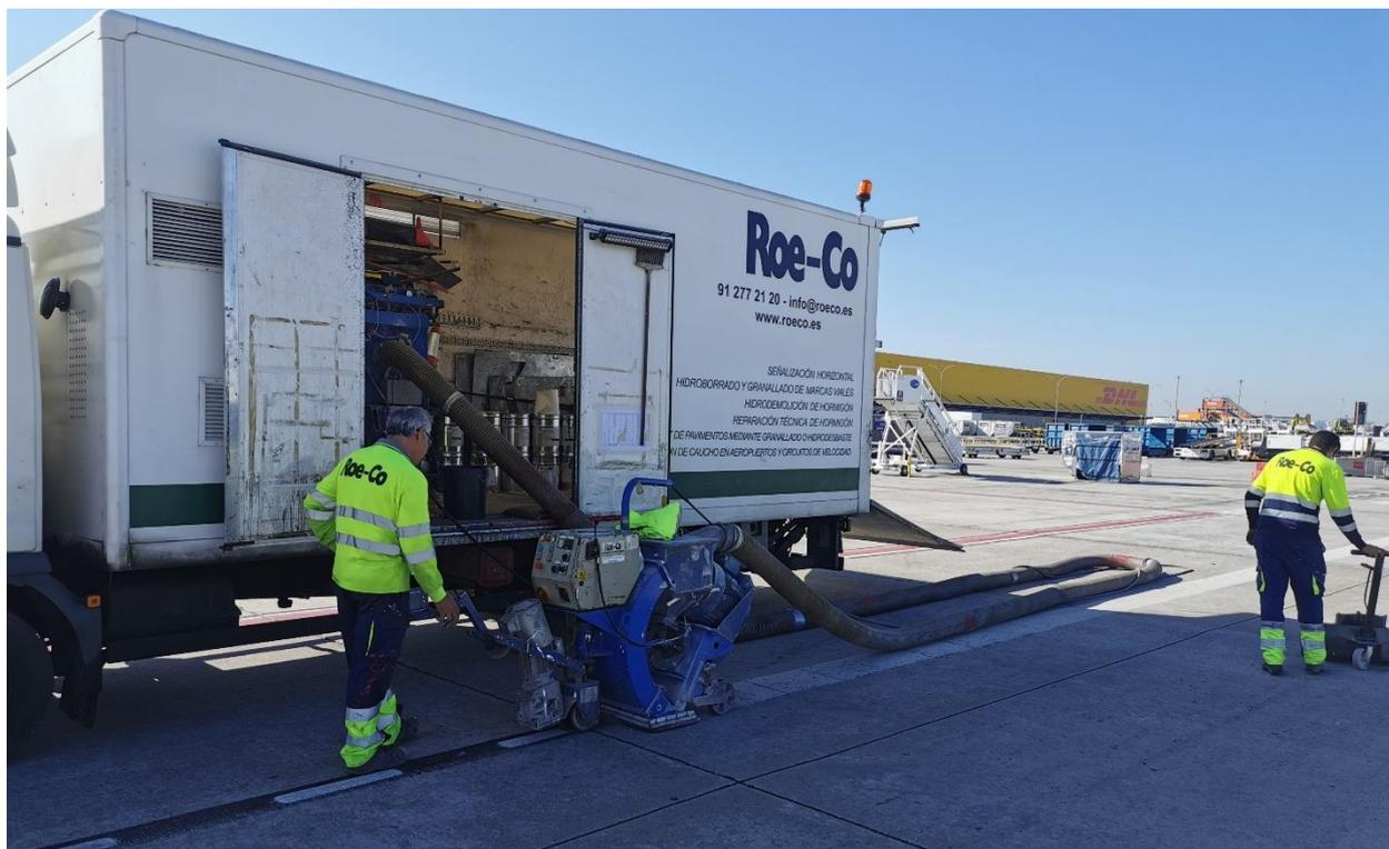
Igualmente, la granalladora se usa en pavimentos de hormigón para dar un **tratamiento previo** que abra el poro y elimine la membrana de curado. De esta manera, y con una posterior imprimación se garantiza la correcta adhesión de la pintura al firme.
