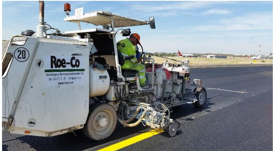
**Máquina Manual Airless:** Se trata de máquinas de manejo manual. Se utilizan fundamentalmente para la ejecución de los carteles y símbolos que no se pueden hacer con una máquina automática. Se trata de máquinas que echan
